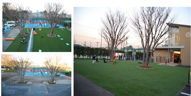
工事中の風景
